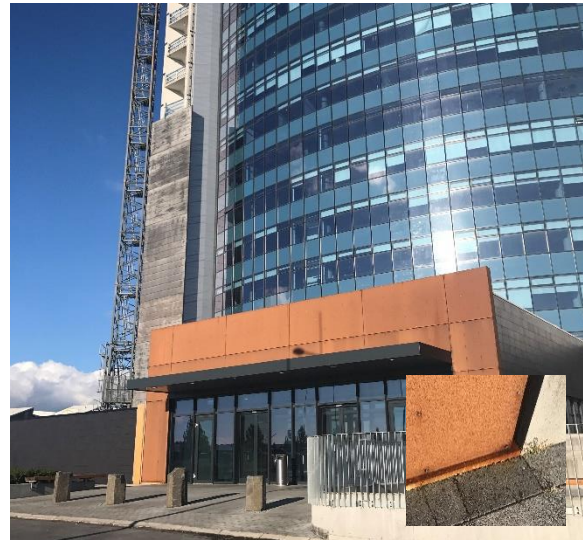
MYND 22 Inngangur Norðurturns Smáralindar er klæddur hægtryðgandi stáli. Framkvæmdir eru enn í gangi (Efla, 2017).
