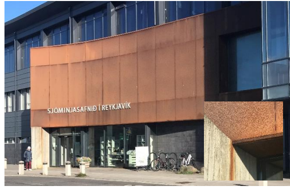
MYND 20 Inngangur Sjóminjasafnsins í Reykjavík er klæddur hægtryðgandi stáli. Ryð úr hægtryðgandi stálinu hefur smitað steypuna fyrir neðan (Efla, 2017).
