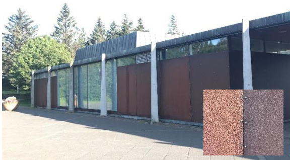
MYND 15 Kjarvalsstaðir í Reykjavík eru klæddir hægtryðgandi stáli, að hluta til hefur verið skipt um klæðningu (Efla, 2017).
