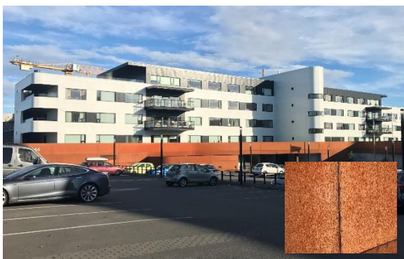
MYND 17 Bílakjallari hjúkrunarheimilisins Mörk er klæddur hægtryðgandi stáli (Efla, 2017).
